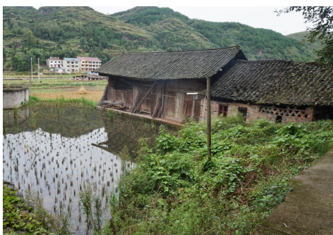
上为刘济洪家兴建中的房舍， 下为原有房舍
